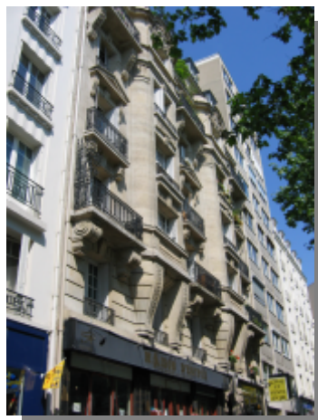
Paris 14ème - Bel immeuble parisien de 22 logements. Changement des menuiseries, création de la ventilation et remplacement du chauffage. Travaux livrés en 2008.
